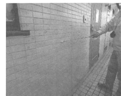
「外部（外壁）」調査の様子
