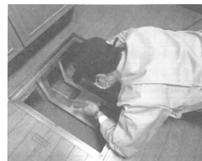
「土台・床組、基礎」調査の様子
