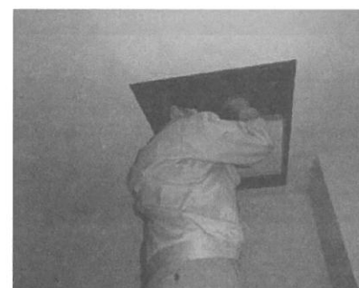
「小屋組・梁」調査の様子
